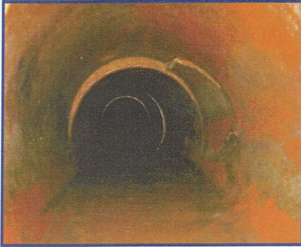
施工前の管内状況(例)
