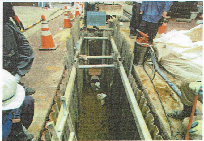
下水道本管を取替えています
