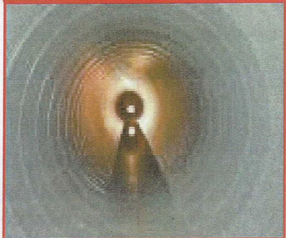
施工後の管内状況(例)
